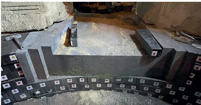
Fig. 6 Slagdoor installed
